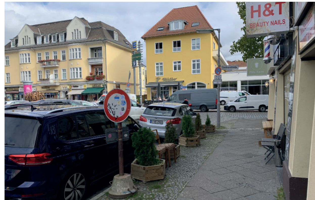
schmaler Gehweg (fehlender Oberstreifen, zugestellter Unterstreifen), kaum Platz für Außengastronomie; Oberflächenschäden
